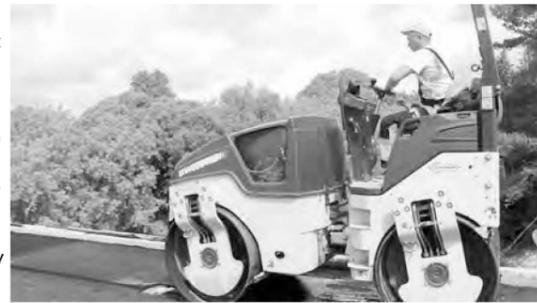
мосту - новой дороге - выполнены работы по укладке щебеночного основания и нижнего слоя покрытия из асфальтобетонной смеси.
